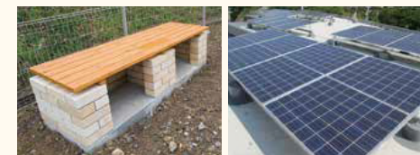
防災かまど付きベンチ 屋上に設置された太陽光発電施設
