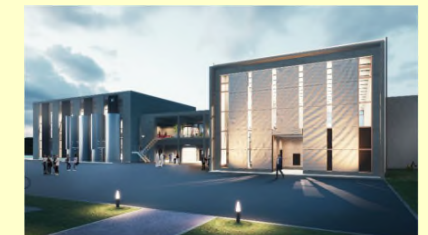
フルPC建築の「福島RDMセンター」(會澤高圧コンクリート㈱ホームページより)
